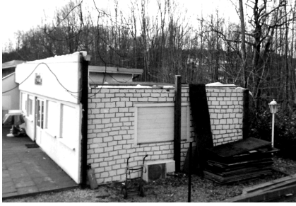
Das Vereinsheim bekommt ein neues Dach
