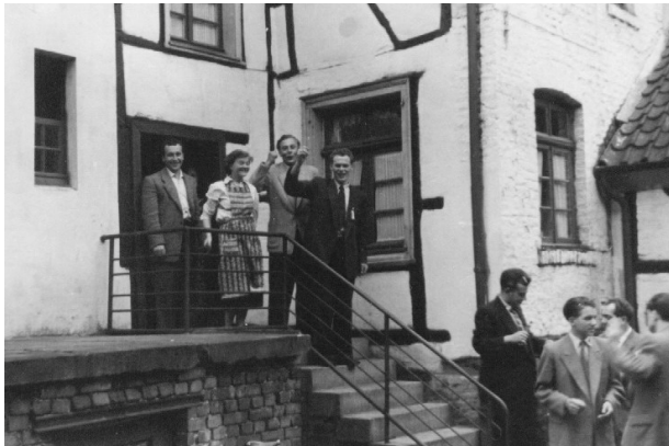
Unten links am Bildrand die Waschküche (Umkleide)
