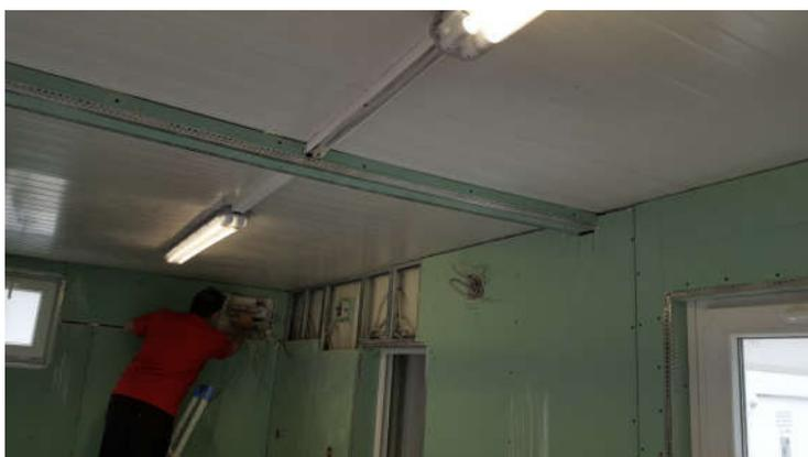
So konnte G. Conze im Alleingang zunächst in dem einen Container die Rigips Platten anbringen, während im anderen Container P. König die Elektroinstallation vornehmen konnte. Gleichzeitig wurde im Duschcontainer von der Fa. Wappler unter Mithilfe von unserem Platzwart P. Rang die Wasserleitungen für die Duschen verlegt.
