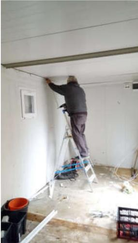
Nachdem alle Leitungen und Rohre entfernt waren, wurden die Verbindungen zwischen den Containern aufgeschnitten, sodass man seit Mitte November bereits von einem Container zum anderen Container durchgehen kann.
